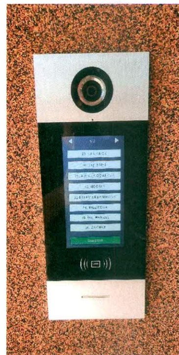
GVS Vonkajšia jednotka. Dotykový panel SMART 7P
